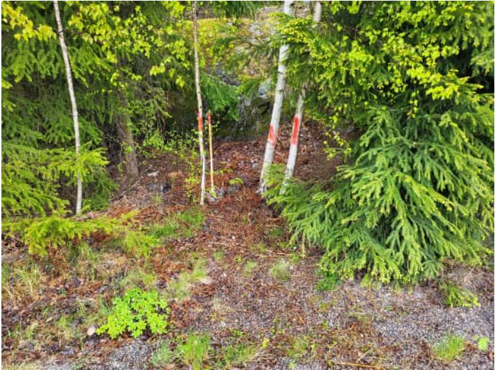
2 träd. Nytt kabelskåp.
